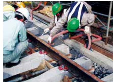
※防振まくらぎとRWG-Nを使用した省力化軌道の施工例
