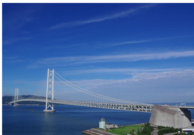
明石海峡大橋
