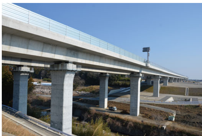
新名神高速道路 鈴鹿高架橋
