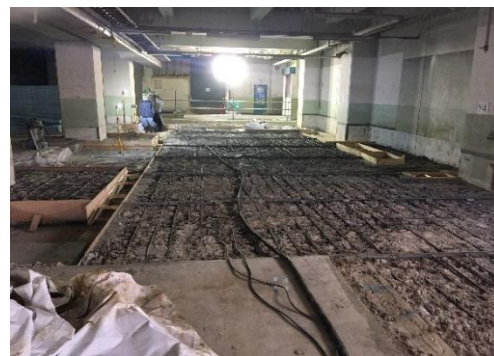
写真 9. 工場の断面修復
