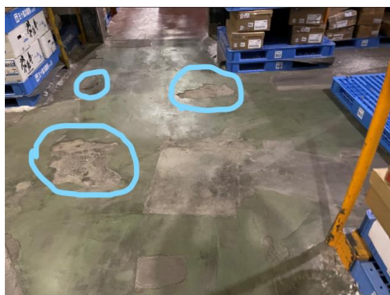
図1. 冷凍冷蔵倉庫の不具合事例とフォークリフト(イメージ)
