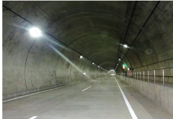
国道357号 東京港トンネル(東行き)[東京都]
