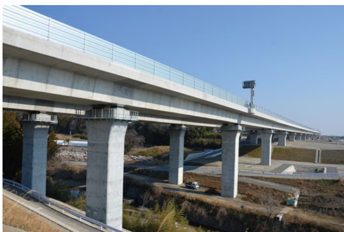
新名神高速道路 鈴鹿高架橋
