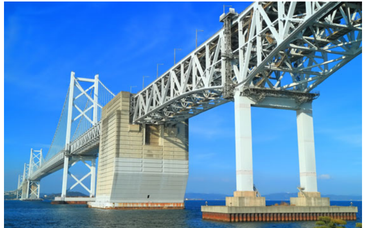
備讃瀬戸大橋
