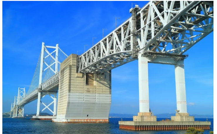
備讃瀬戸大橋
