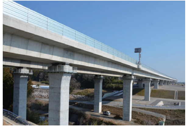
新名神高速道路 鈴鹿高架橋 [三重県]
