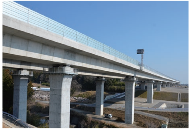
新名神高速道路 鈴鹿高架橋 [三重県]
