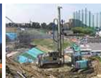
機械攪拌機での施工
