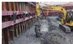
機械攪拌機での施工
