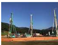
機械攪拌機での施工
