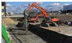
機械攪拌機での施工
