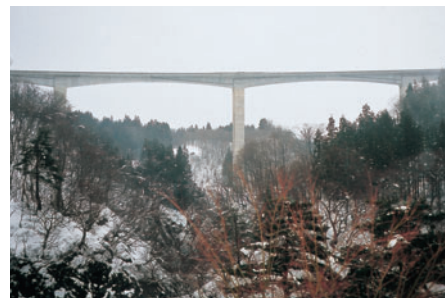
山形自動車道小網川橋
