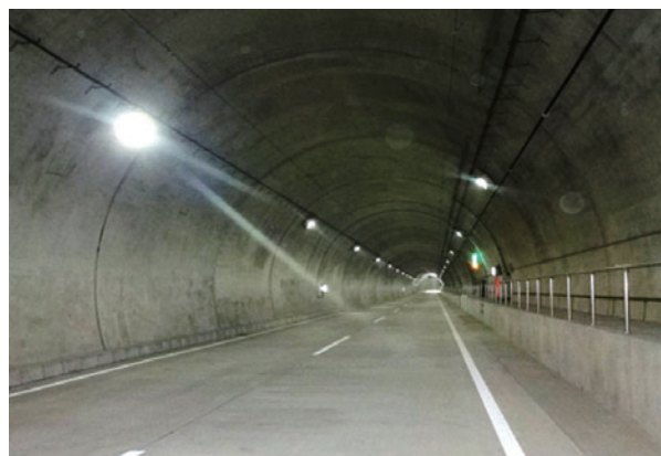
国道 357号 東京港トンネル(東行き)[東京都]
